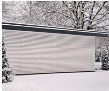
Die Garagentore sind in die weiße Holzverschalung bündig integriert und dadurch kaum sichtbar.
