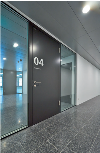
Im gesamten Gebäude wurden Brand-, Rauch- und Schallschutztüren aus Holz von Schörghuber verbaut – auch im Keller und in der Tiefgarage.
