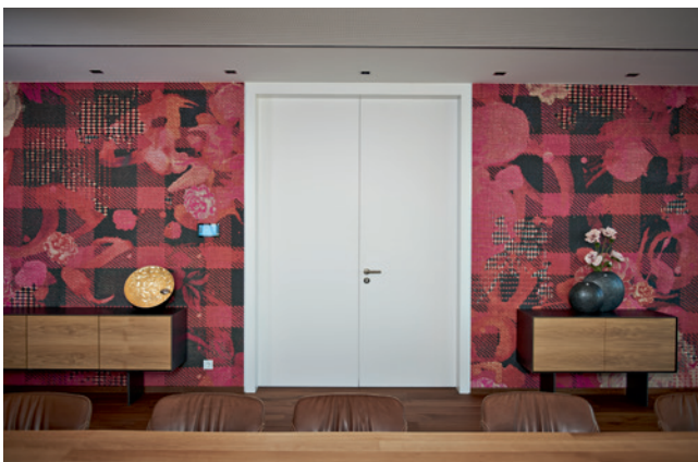
Brand- und Schallschutztür mit Holzfutterzarge ohne Zierfalz.
