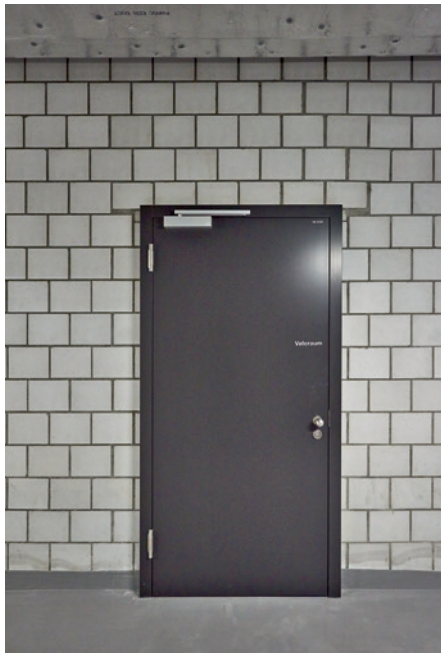
Im gesamten Gebäude wurden Brand-, Rauch- und Schallschutztüren aus Holz von Schörghuber verbaut – auch im Keller und in der Tiefgarage.
